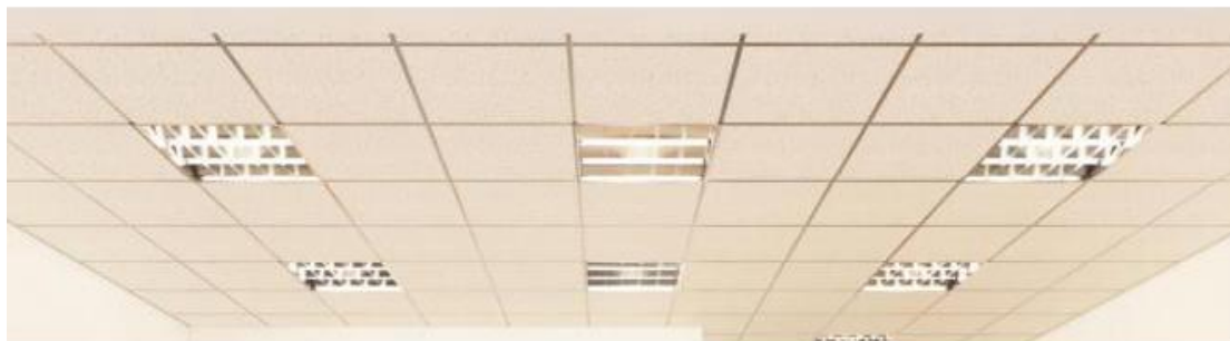
01 矿棉板吊顶示意
